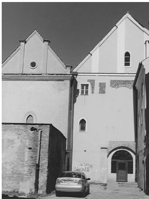
ŚWIDNICA. ELEWACJA TYLNA RATUSZA I POZOSTAŁOŚCI WIEŻY fot. M. Staffa
