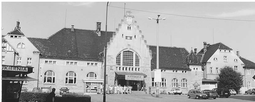
ŚWIDNICA. DWORZEC KOLEJOWY fot. M. Staffa
